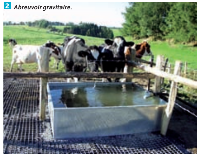
1 Pompe alimentée par de l'énergie photovoltaïque pour remplissage d'une cuve à 1,5 m et écoulement par gravité dans deux cuves.
